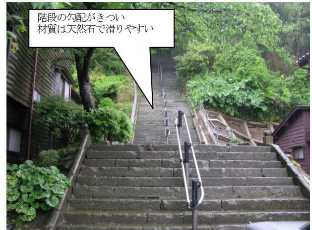
写真-2 階段の現状（この上に高台がある）
